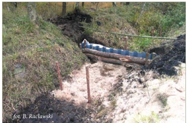
Eksperymentalna budowa zastawki z wykorzystaniem plastikowej przegrody Experiments with plastic barriers
