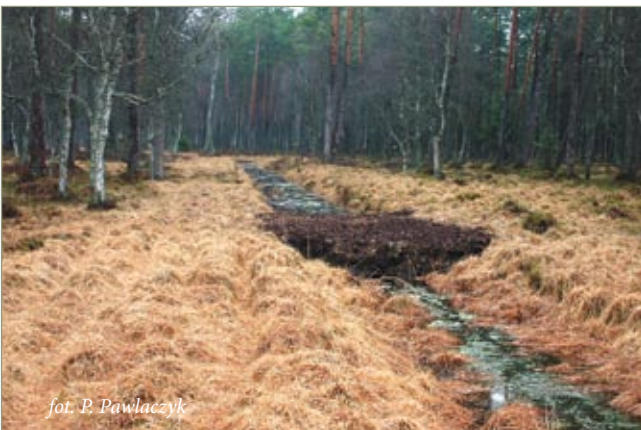
Odcinkowe zasypianie rowu Partial ditch filling
