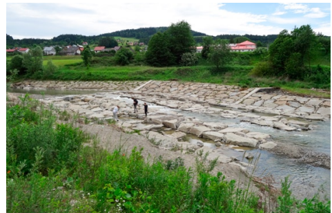
Fot. 2. Przebudowane stopnie w Grybowie (po lewej) oraz w Kąclowej (po prawej) (fot. Marek Jelonek). Photo 2. Rebuilt weirs in Grybów (left) and Kąclowa (right) (photo by Marek Jelonek).
