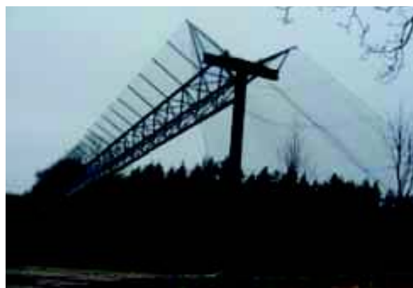
Fot. 8. Widok od strony pobocza drogi na bramownicę Fot. JacYk, www.skyscrapercity.com
