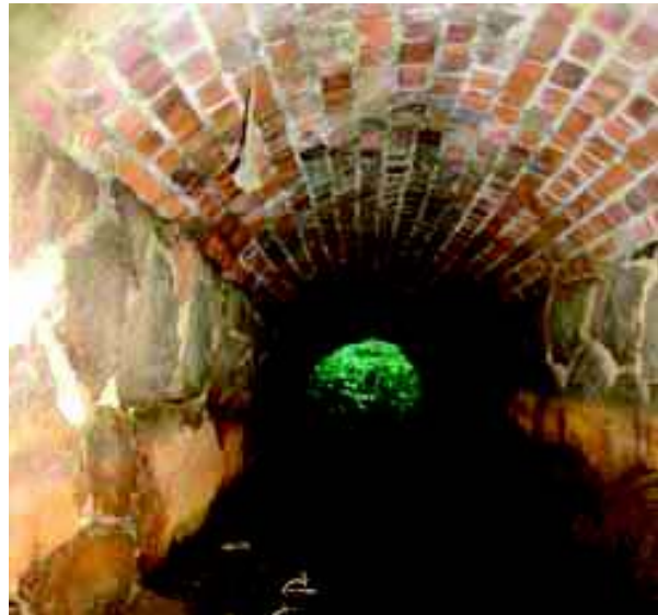
Fot. 2. Przepusty pod drogami budowane z kamienia i cegły z licznymi szczelinami mogą stanowić zimowisko nietoperzy. Fot. Grzegorz Gołębnik.
