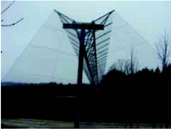
Fot. 9. Widok od strony pobocza drogi na bramownicę. Zwraca uwagę niewielka szerokość powierzchni po której mają przelatywać nietoperze fot: JacYk, www.skyscrapercity.com
