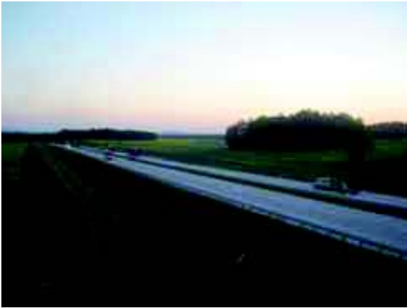
Fot. 1. Droga biegnąca po nasypie. Fot. Grzegorz Gołębnik.
