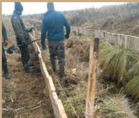
Fot. 1. Wytyczenie linii przebiegu ścianki.
