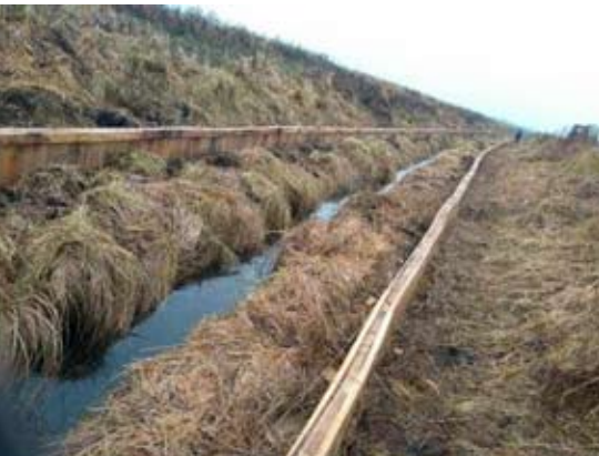
Ścianka prawie na ukończeniu.
