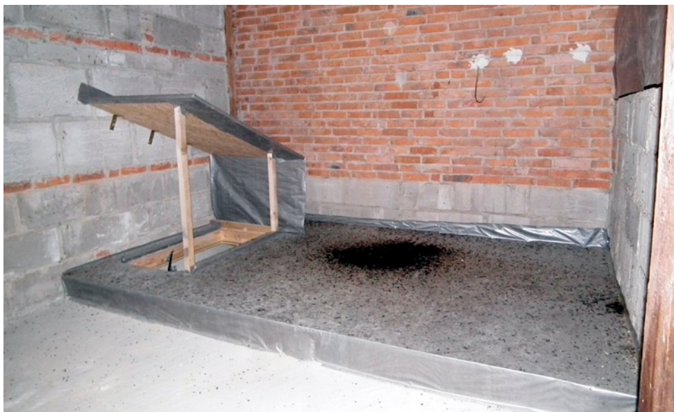
Fot. 2. Platforma gromadząca guano nietoperzy. Wejście na strych widoczne po lewej (fot. M. Warchałowski). Photo 2. The platform collecting bat guano. An attic exit is visible on the left (photo by M. Warchałowski).
